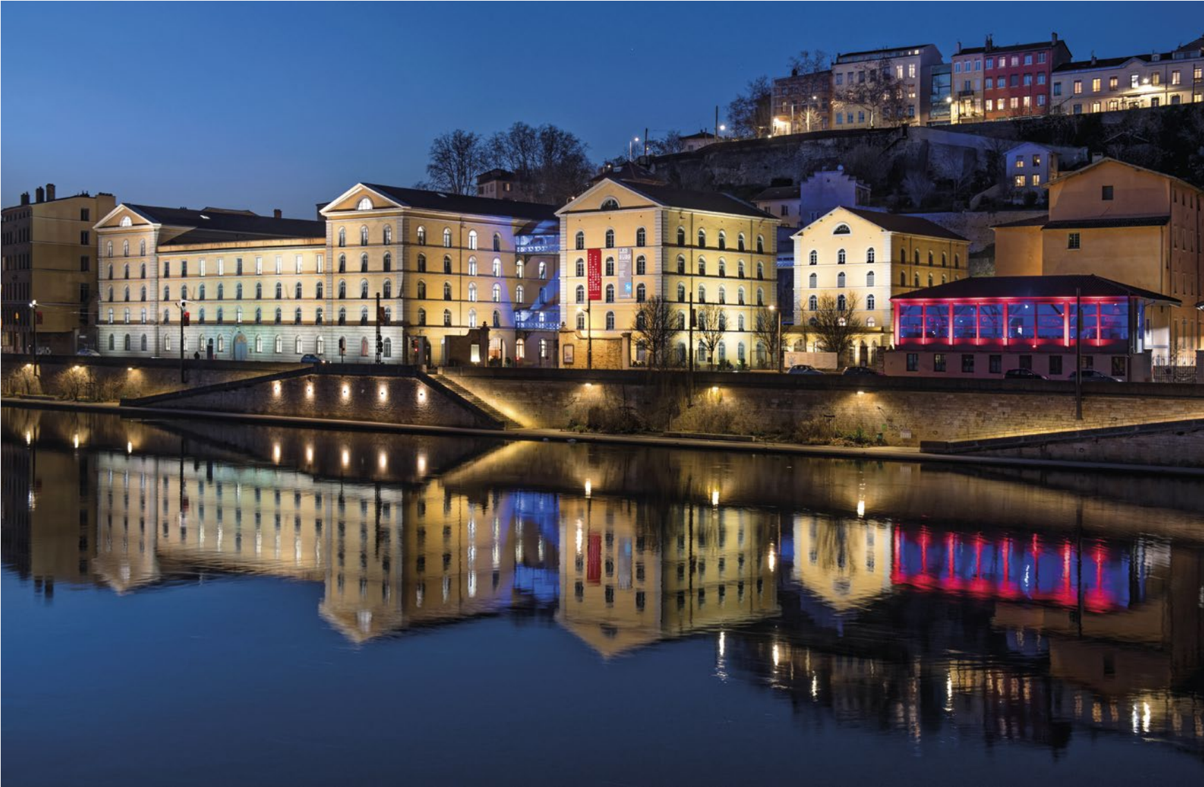
Ancien couvent puis lieu de stockage de nourriture pour l'armée, les Substances abritent aujourd'hui un laboratoire de création artistique et, depuis 2007, l'École nationale supérieure des beaux-arts de Lyon. First a monastery, then a warehouse for army rations, les Substances now are home to an artistic creation laboratory and since 2007, the Lyon National Higher School of the Fine Arts.
